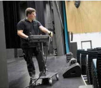
Mit dem mobilen Bedientableau steuert der Mitarbeiter den beweglichen Boden.
